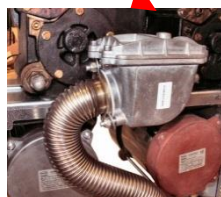
Figure 14 Amorce des pompes d'aspiration
